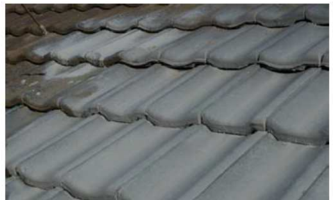
Aufspritzen der Dachbeschichtung
