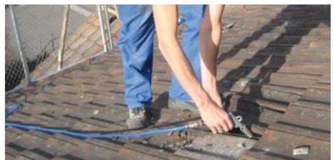
Reinigen des Überlappungsbereich mit Druckluft
