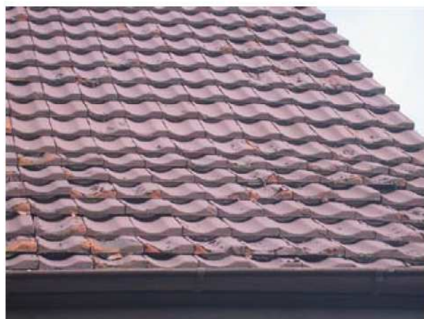
Schadhafte Beschichtung
