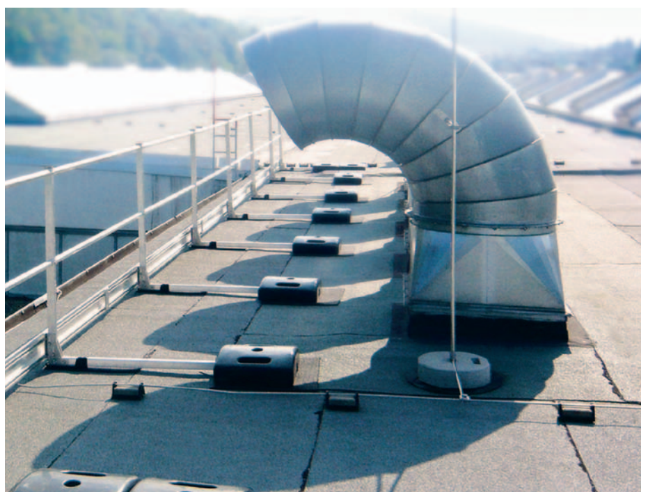
Kollektivschutz am Dachrand
