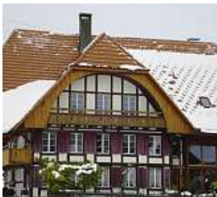
Fachgerecht geplant und eingebaut bieten Schneehalter eine ausreichend hohe Sicherheit gegen das Abrutschen von Schnee von steilen Dächern.
