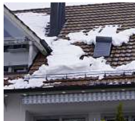
Um Schäden zu verhindern, empfiehlt sich, bei steil geneigten Dächern in Ergänzung zu Schneefangrohren auch Schneehalter einzubauen.
