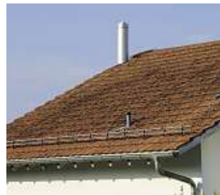
Bei flach geneigten Dächern bieten Sicherungselemente wie Schneefangrohre bereits eine ausreichende Schneesicherung.
