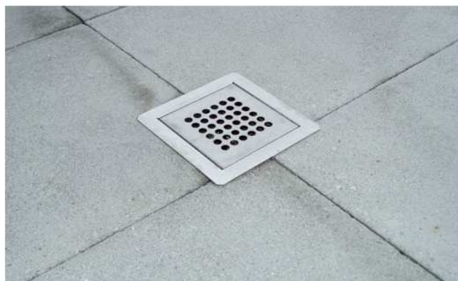
Abb. 17: Dachwassereinlauf: Lochrost
