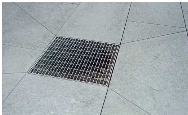
Abb. 16: Dachwassereinlauf: Gitterrost
