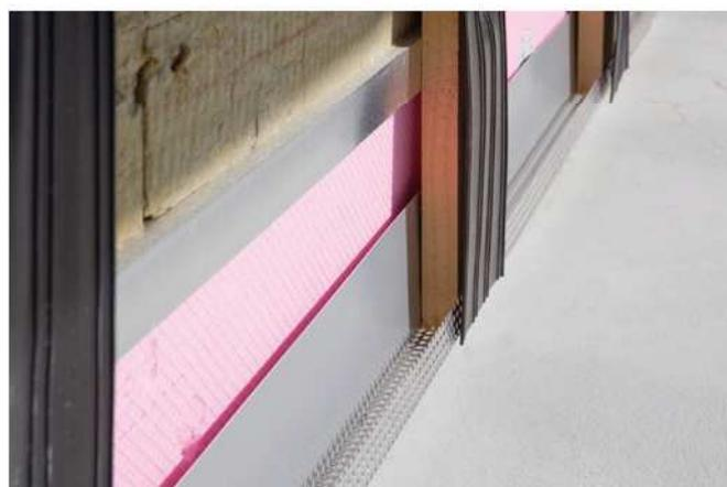
Abb. 1: Sockeldämmung
