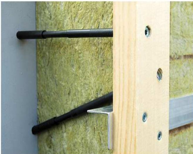
Abb. 2: System mit Distanzschrauben (Rogger)
