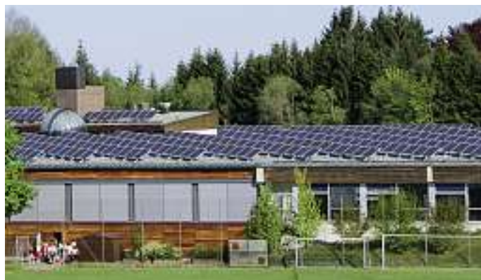
FOTO: GEBÄUDEHÜLLE SCHWEIZ
