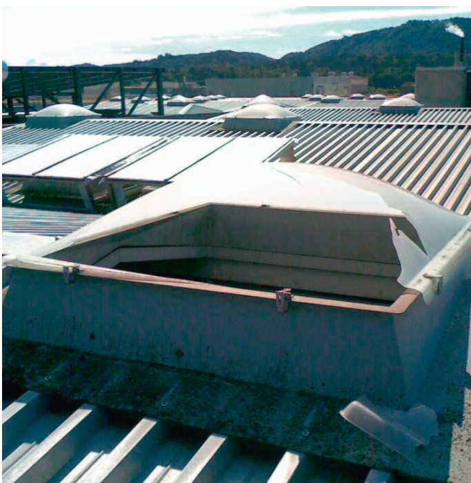
Oblichter (Lichtkuppeln), durch die Personen abgestürzt sind
