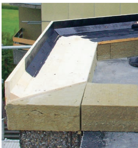
Diverse Fassadeneinsprünge, Niveauabsätze, Brüstungsisolierungen und Dachranderrhöhungen erforderten viel Detailarbeit, was den Zeit- und Kostenaufwand erhöhte.
