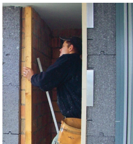
Bau der VH-Fassade: auf die Vertikallattung werden anschliessend Eternitplatten montiert.
