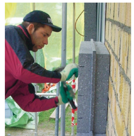
Anbringen einer 18 cm EPS-Dämmschicht.
