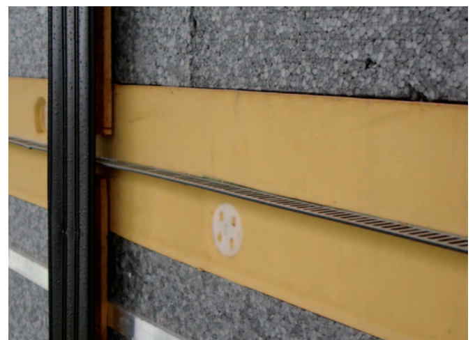
Abb. 5: Brandriegel; Fassadensystem SwissporLAMBDA Vento
