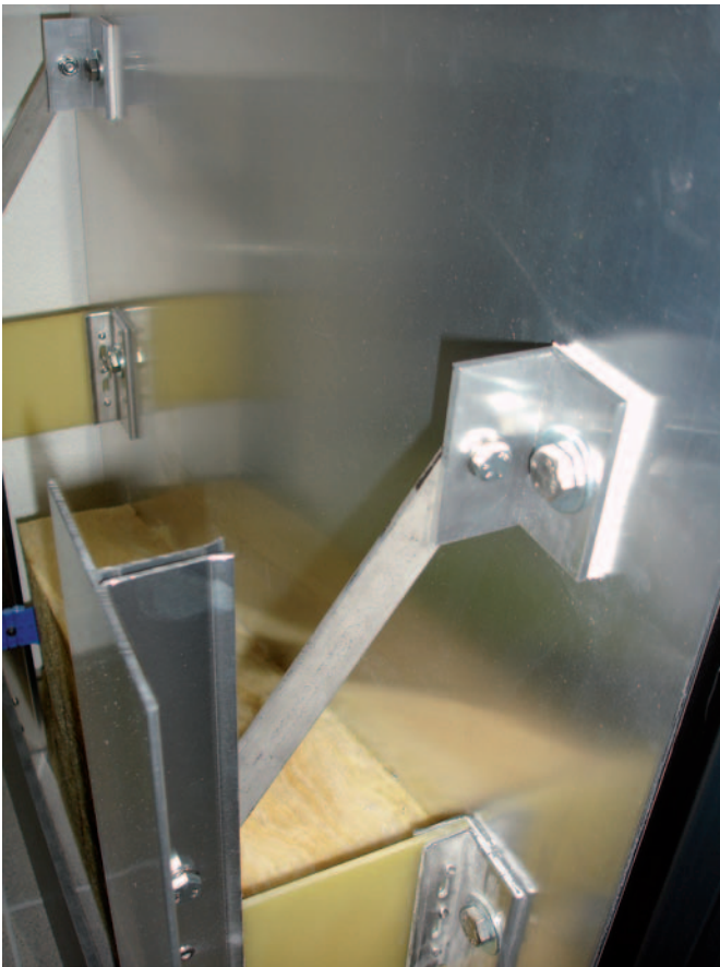
Abb. 6: Rückhaltesicherungen Fassadensysteme; WDK PHOENIX von Wagner System
