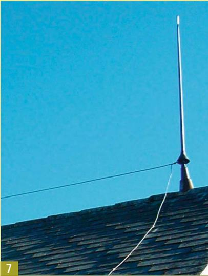
7 Fangstange mit Ausgleichs- und Ableitung bei einem Gebäude mit exponierter Lage (ca. 1945).
