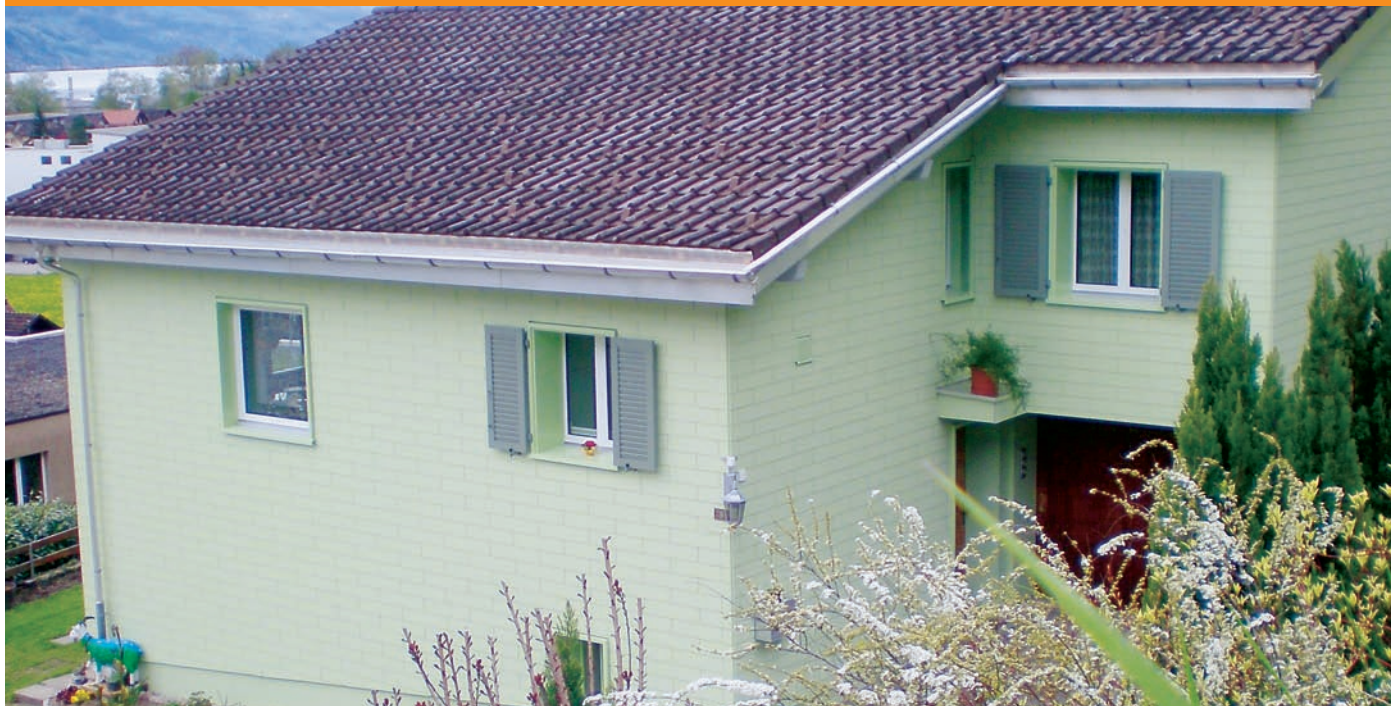
Renovieren macht sich bezahlt: Dieses EFH in Walenstadt wurde beispielhaft und nachhaltig renoviert (Gebäude vorher und nachher). Rund 7% der investierten Bausumme erhielt der Bauherr in Form eines Förderbeitrags der Stiftung Klimarappen.
