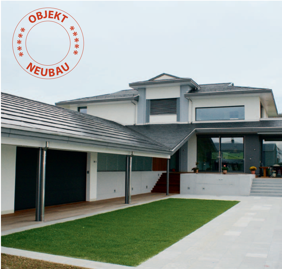
Hohe, nachhaltige Qualität hinsichtlich Architektur, Materialisierung und Energieeffizienz: Naturschieferdeckung und 150 m 2 Photovoltaik-Module auf dem südgerichteten Zwischentrakt.
