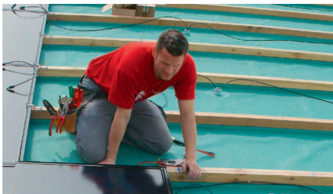
Dacheindeckung im Frühjahr 2010
