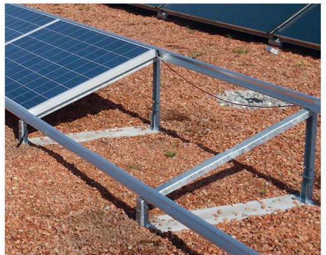
Einbau der Flachdachaufständerung auf einer Druckverteilungsplatte (Betonsockel)
